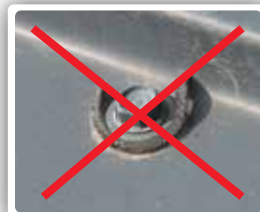
Skrutky tohto typu sa pri montáži krytín Metrotile nepoužívajú
